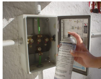
Área de cobre a proteger con antiox.
